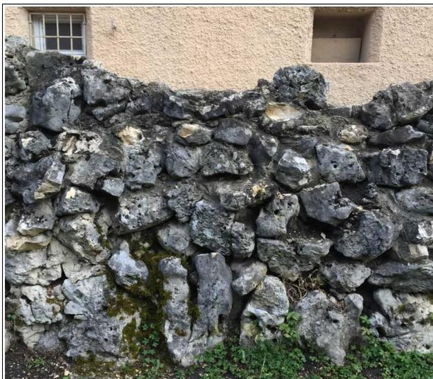
Abb. 19: Vermörtelte Mauer aus Jura-Bruchsteinen ohne grabbare Fugen und Rückraum.
