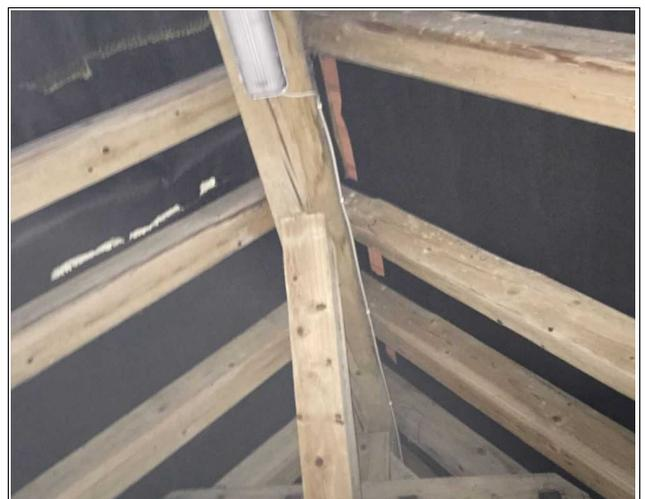
Abb. 14: Gebälk geschlossen mit neuer Dampfbremse.
