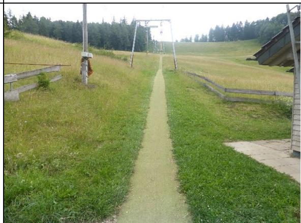
Mit Bodenschutzmatten ausgelegte Liftrasse im Bereich der Talstation (Skisport- und MTB-Downhill – a bauliche Anlage Lift)
