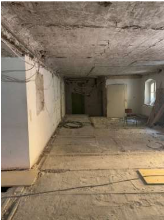
Entkernung der Räumlichkeiten
