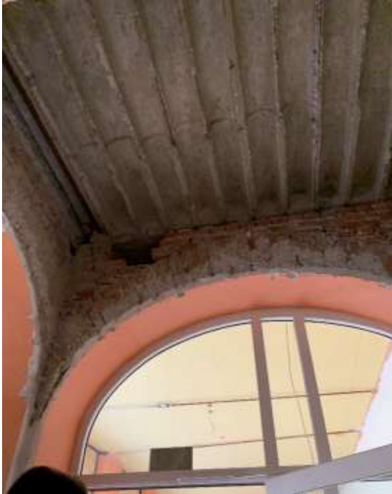
Schadhafte Rippendecke Flur EG
