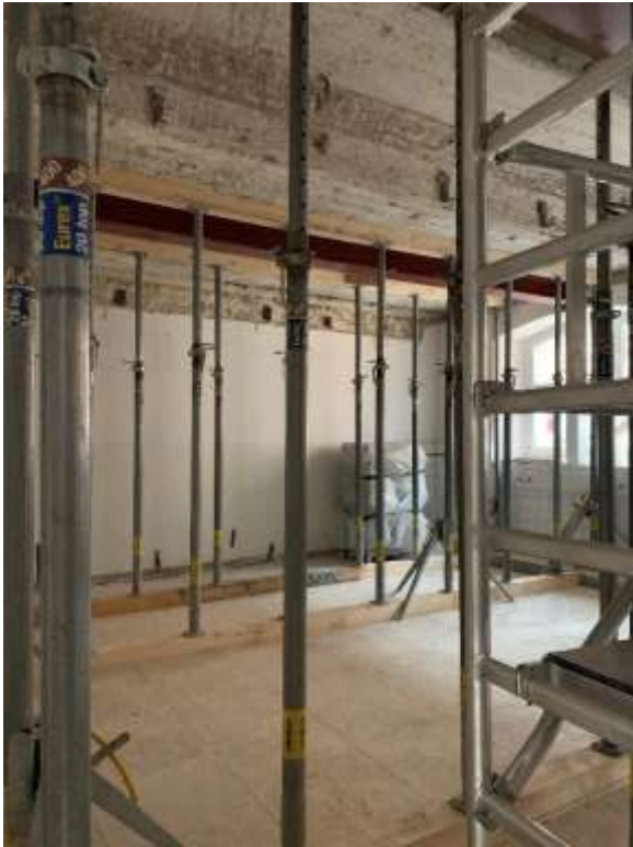
Abstützung der UG Decke zur Sicherung der Lastabtragung EG
