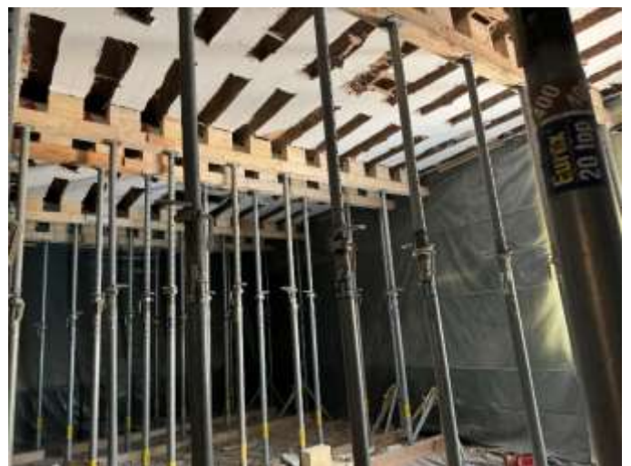
Schadhafte Rippendecke Flur EG
