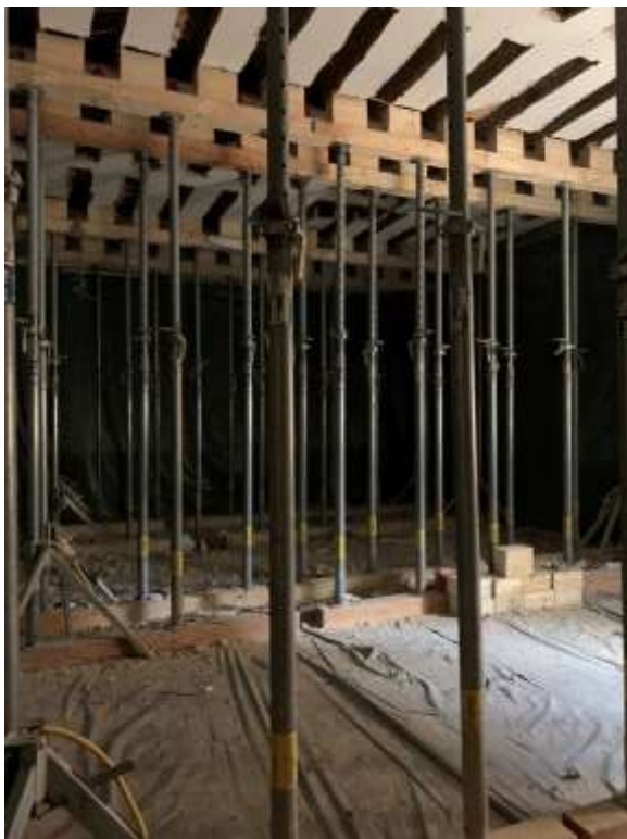
Abstützung der EG Decke zur Sanierung und Abtragung der Lasten
